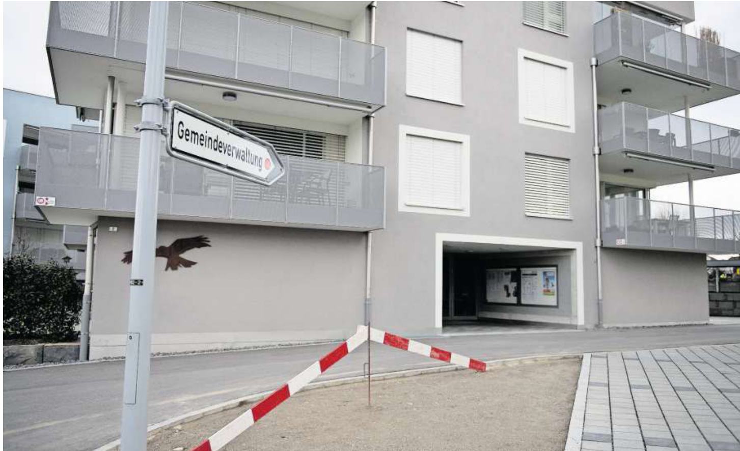
In diesem Gebäude ist die Gemeindevverwaltung von Mauensee beheimatet.
