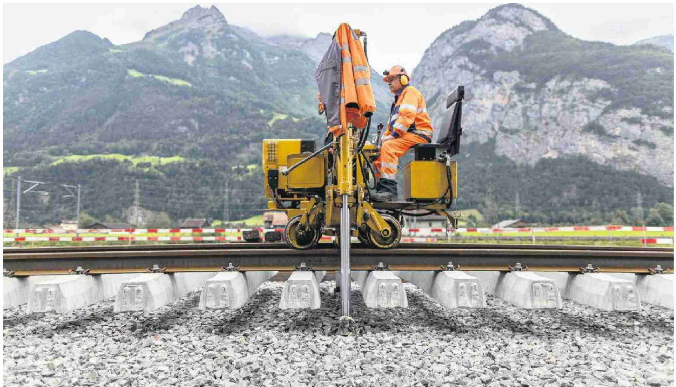
Ein Arbeiter verlegt auf der Neat-Strecke bei Erstfeld Schienen.
