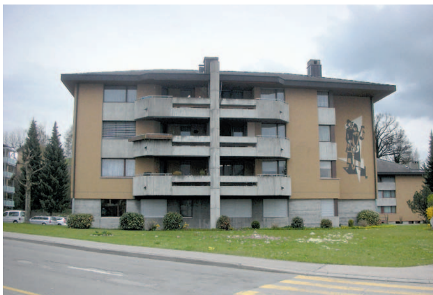
Das Mehrfamilienhaus vor der Sanierung.
